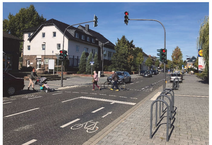
Bilder 17 und 18 | Signalisierungsform „Dunkelampel“: im Normalfall „dunkel“ für den Fahrverkehr und „Rot“ in der Furt (linkes Bild), im Bedarfsfall „Rot“ für den Fahrverkehr und „Grün“ in der Furt (rechtes Bild)
