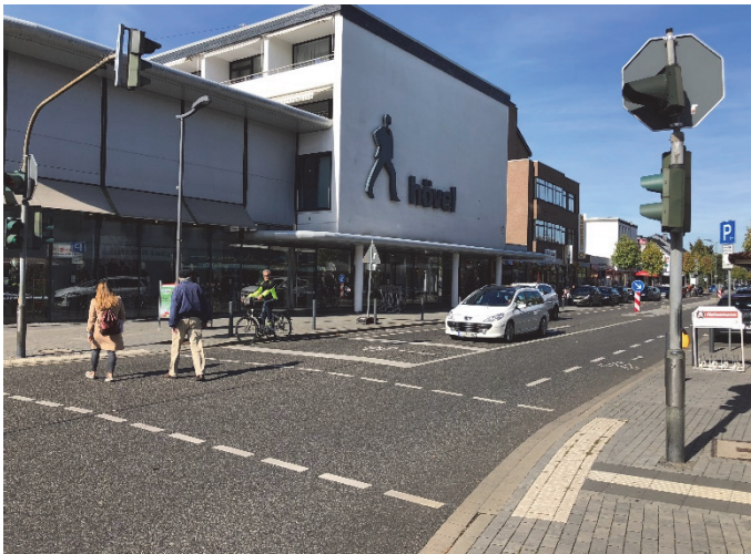
Bilder 32 und 33 | Radverkehrsführung am signalisierten Knotenpunkt: Die aufgeweitete Wartefläche vor der Kfz-Haltlinie (linkes Bild) wurde abweichend von der ursprünglichen Entwurfsplanung – siehe Bilder 5 oder 32 – realisiert, um Radfahrenden ein sicheres direktes Linksabbiegen zu ermöglichen. Piktogramme und Pfeile sollen dies allen Verkehrsteilnehmenden verdeutlichen. Im Verkehrsalltag (rechtes Bild) zeigt sich, dass der überbreite Fahrstreifen zwei Pkw nebeneinander offenbar nicht genügend Platz bietet.
