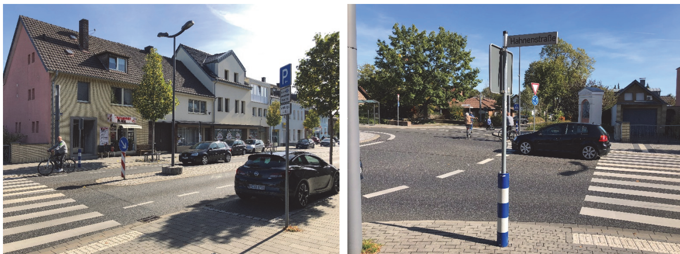
Bilder 36 und 37 | Radverkehrsführung im Kreisverkehr: Radfahrende werden vom Schutzstreifen direkt in die Kreisfahrbahn und anschließend im Mischverkehr auf der Fahrbahn ohne weitere Radverkehrsanlage geführt
