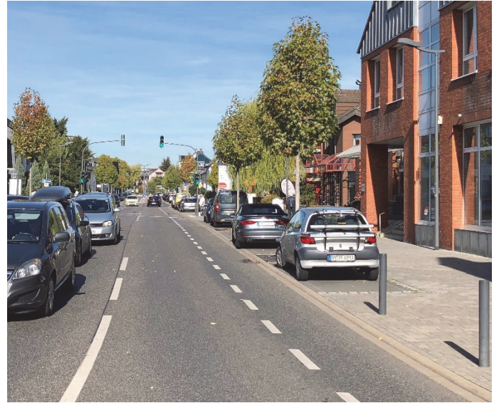
Bilder 9 und 10 | Fahrbahn und Radverkehrsführung: durchgängig markierter Schutzstreifen neben „Kernfahrstreifen“ im Zuge des Mittelstreifens (linkes Bild) bzw. neben einer Kernfahrbahn im Teilabschnitt ohne Mittelstreifen (rechtes Bild)
