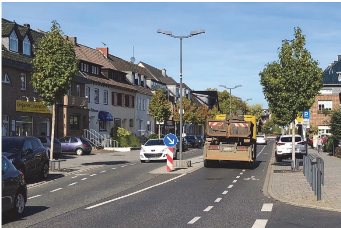
Bilder 11 und 12 | Beim Einsatz von Schutzstreifen typisch: breitere Kraftfahrzeuge nutzen den Schutzstreifen mit, Radfahrende weichen insbesondere bei schmalen Schutzstreifen zum Teil in den Seitenraum aus
