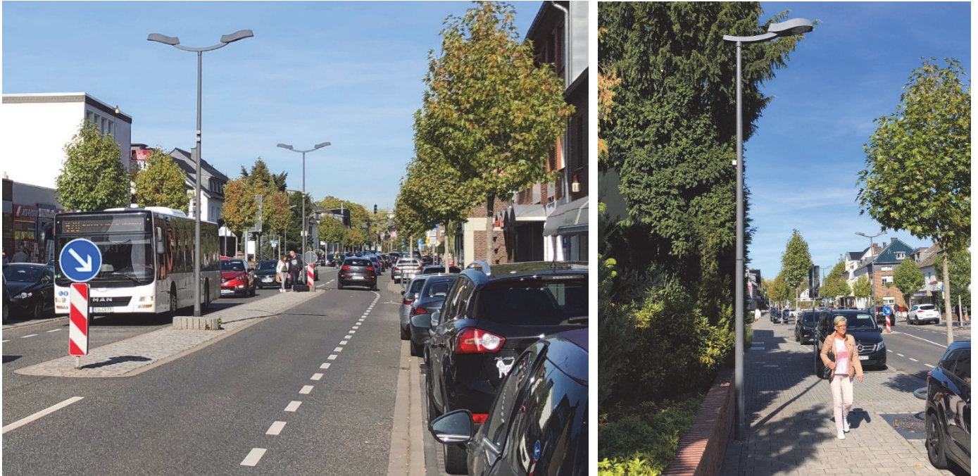
Bilder 39 und 40 | Beleuchtung und Begrünung: Doppelbogenleuchten auf dem Mittelstreifen wechseln mit randständiger Beleuchtung im Teilabschnitt ohne Mittelstreifen, die neuen Baumpflanzungen erzeugen schon rund sechs Jahre nach Fertigstellung der Straße die gewünschte Alleewirkung
