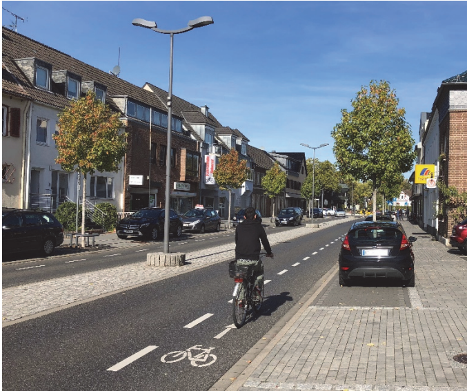
Bilder 9 und 10 | Fahrbahn und Radverkehrsführung: durchgängig markierter Schutzstreifen neben „Kernfahrstreifen“ im Zuge des Mittelstreifens (linkes Bild) bzw. neben einer Kernfahrbahn im Teilabschnitt ohne Mittelstreifen (rechtes Bild)
