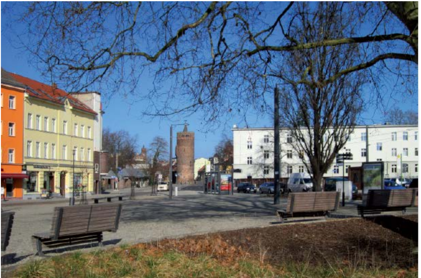
Bild 1 | Der Nicolaiplatz nach der Umgestaltung: Flächenhafte Verbesserung der Aufenthaltsqualität und Bündelung der Verkehrsfunktion am Rand
