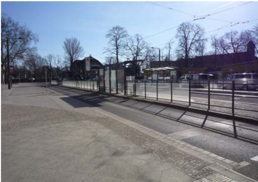
Bilder 17 und 18 | Kombinierte Straßenbahn-Bus-Haltestelle in der Zufahrt zur Magdeburger Straße: asphaltierter Gleiskörper, der von Straßenbahn und Linienbus gemeinsam befahren wird, Bahnsteige in Seitenlage mit Witterungsschutz und Sitzmöglichkeit in hintereinanderliegenden Wartehäuschen, transparente Spritzschutzwände zum parallel verlaufenden Kfz-Fahrstreifen
