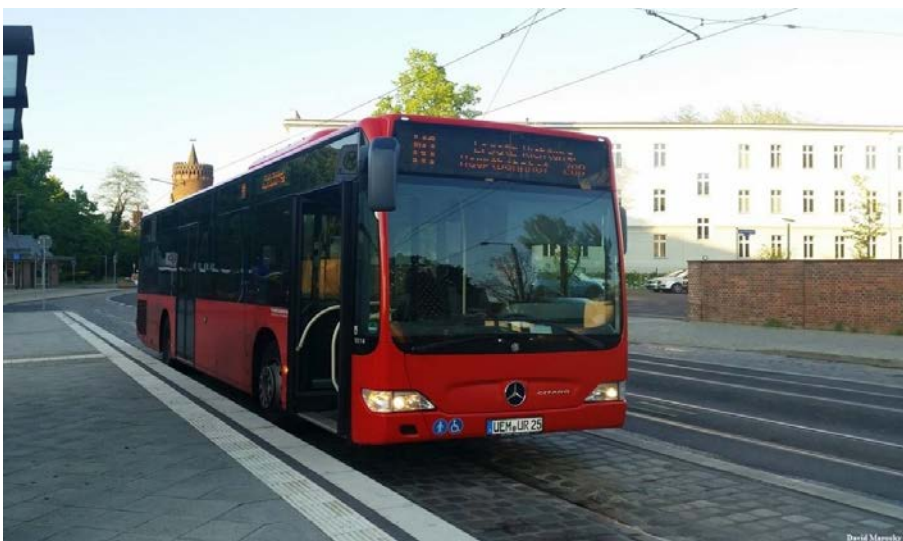
Bild 21 | Busbuchten und Warteflächen in der südöstlichen Fahrbahn (mit Blick zur Plauer Straße): kurze Umsteigebeziehungen durch hintereinanderliegende Haltepositionen, kontrastreiche Haltekante, mittig der Bucht verlaufende Entwässerungsrinne
