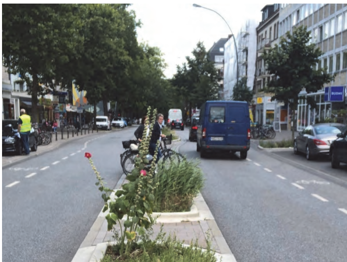
Bilder 23 und 24 | Querender Radverkehr im Streckenabschnitt: 2,00 m breite Mittelstreifen reichen nicht ganz aus (linkes Bild), der 4,00 m breite Mittelstreifen stellt dagegen auch für Radfahrende eine komfortable und sichere Überquerungshilfe dar (rechtes Bild)
