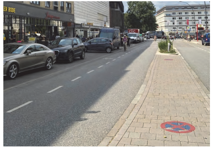
Bilder 18 und 19 | „Multifunktionsstreifen“ im südlichen Ausbaubereich: langgezogene Mittelstreifen mit barrierefreien Überquerungsflächen, links ein 2,00 m breiter Teilabschnitt mit Staudenbepflanzung, Poller und dazwischenliegenden barrierefreien Überquerungsstellen, rechts ein 2,00 m breiter Teilabschnitt ohne Einbauten
