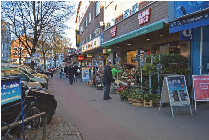
Bilder 3 bis 5 | Die Osterstraße vor der Umgestaltung: breite Fahrbahnen ohne gesicherte Überquerungsangebote in den Streckenabschnitten, unübersichtliche und weitläufige Knotenpunkte, nicht (mehr) StVO- und regelwerkskonforme Radwege sowie zu knappe Flächen für Gehen, geschäftliche Nutzungsbedarfe und Aufenthalt im Seitenraum
