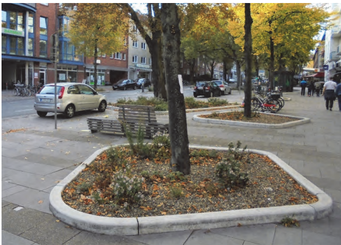
Bilder 38 und 39 | Baumbestand: großzügig dimensionierte Beete mit sparsamer Unterpflanzung schützen den Wurzelbereich und bilden durch ihre unregelmäßige, organische Grundform ein attraktives Gestaltungselement im Seitenraum
