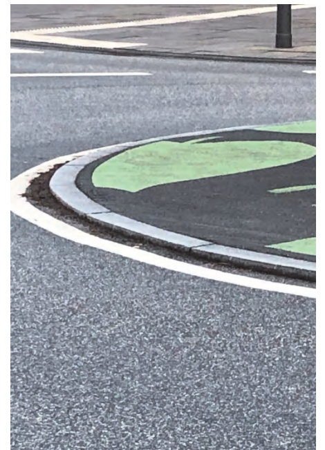
Bilder 28 und 29 | Minikreisverkehr Osterstraße / Methfesselstraße / Müggenkampstraße: Ausführung mit 18 m Durchmesser, umlaufenden Fußgängerüberwegen, farbig gestalteter überfahrbarer Kreisinsel mit geringem Anschlag des Bordes zur Kreisfahrbahn, aufgrund der beengten Gesamtsituation lediglich angedeutete, oval markierte „Fahrbahnteiler“ zwischen Zu- und Ausfahrt
