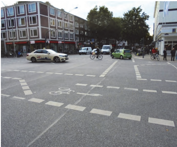
Bild 33 und 34 | Knotenpunkt Osterstraße / Heußweg: markierte, großzügig dimensionierte Aufstellfläche für Radfahrende zum indirekten Linksabbiegen (linkes Foto), beide Angebote zum Linksabbiegen werden gut genutzt (rechts)
