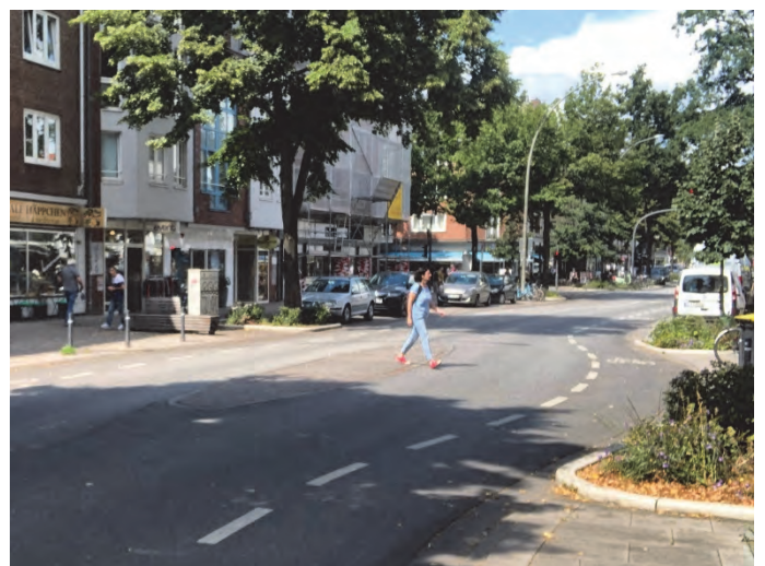
Bilder 14 und 15 | Mittelinseln im Abschnitt nördlich des Heußwegs: niveaugleich ausgebaute, schmale ellipsoide Grundform, hier links mit Mittenbaum, Pflanzbeeten und mehreren dazwischenliegenden Warteflächen für Zufußgehende, rechts als niveaugleich ausgebildete Version ohne Einbauten
