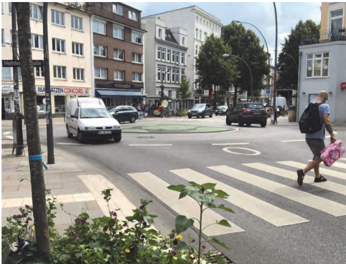
Bilder 30 und 31 | Minikreisverkehr Osterstraße / Methfesselstraße / Müggenkampstraße im Nutzungsbild: markierter „Minifahrer“ zwischen Kreisfahrbahn und Fußgängerüberweg (Bild links); der gewählte Durchmesser erlaubt auch kleinen Lkw eine Befahrung ohne Überfahren der Mittelinsel
