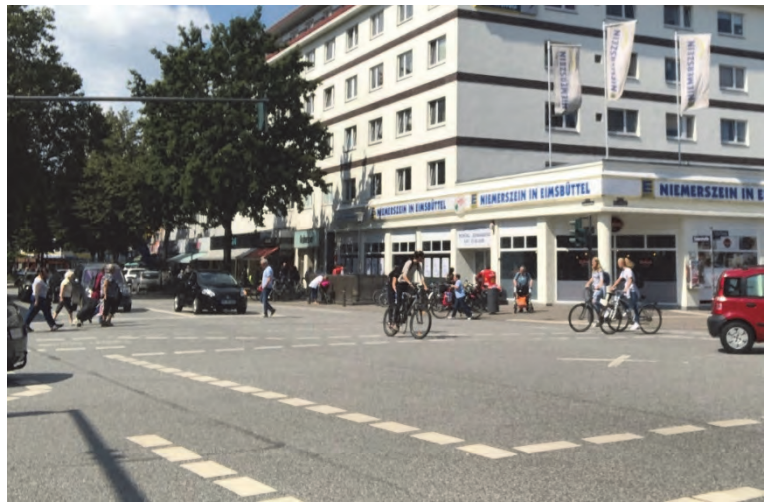
Bild 33 und 34 | Knotenpunkt Osterstraße / Heußweg: markierte, großzügig dimensionierte Aufstellfläche für Radfahrende zum indirekten Linksabbiegen (linkes Foto), beide Angebote zum Linksabbiegen werden gut genutzt (rechts)
