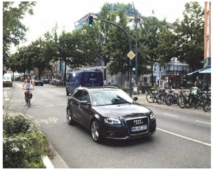
Bilder 26 und 27 | Radverkehrsführung: trotz regelwerksgerechter Fahrbahnbreite von 7,50 m sind hier abschnittsweise wechselnd nur in einer Fahrtrichtung ein Schutzstreifen, in der Gegenrichtung dagegen Fahrrad-Piktogramme auf der Fahrbahn markiert; im Bild rechts ist der Wechsel des Schutzstreifens von vorne rechts nach hinten links sichtbar; im Lageplan links ist darüber hinaus der 0,62 m breite Sicherheitstrennstreifen neben Längsparkständen bzw. Anlieferflächen erkennbar
