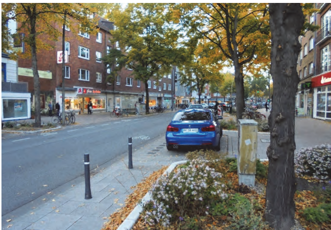
Bilder 45 und 46 | Parken im Seitenraum: 2,50 m tiefe Längsparkstände ermöglichen flexibel auch die Ausweisung als Ladezone; zum Fahrbahnrand bzw. Schutzstreifen ist zusätzlich ein 0,62 m breiter Sicherheitstrennstreifen angeordnet; Poller verhindern Parken auf dafür nicht vorgesehenen Flächen
