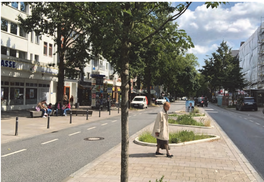
Bild 17 | „Multifunktionsstreifen“ im südlichen Ausbauabschnitt: langgezogene Mittelstreifen mit barrierefreien Überquerungsflächen zwischen Baum- und Pflanzbeeten, hier im 4,00 m breiten Teilabschnitt
