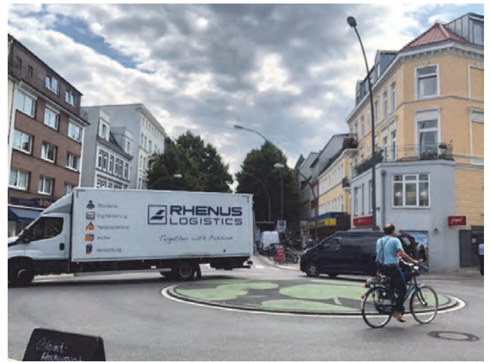
Bilder 30 und 31 | Minikreisverkehr Osterstraße / Methfesselstraße / Müggenkampstraße im Nutzungsbild: markierter „Minifahrer“ zwischen Kreisfahrbahn und Fußgängerüberweg (Bild links); der gewählte Durchmesser erlaubt auch kleinen Lkw eine Befahrung ohne Überfahren der Mittelinsel
