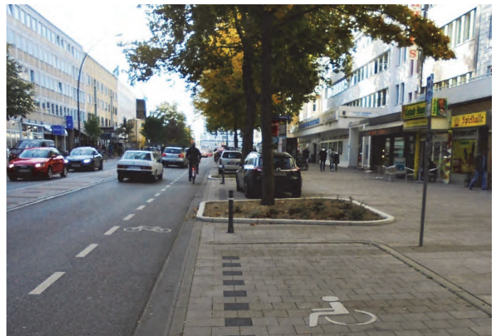
Bilder 45 und 46 | Parken im Seitenraum: 2,50 m tiefe Längsparkstände ermöglichen flexibel auch die Ausweisung als Ladezone; zum Fahrbahnrand bzw. Schutzstreifen ist zusätzlich ein 0,62 m breiter Sicherheitstrennstreifen angeordnet; Poller verhindern Parken auf dafür nicht vorgesehenen Flächen
