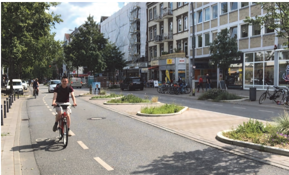
Bild 25 | Radverkehrsführung: im Normalfall auf beiderseits der Fahrbahn markierten, 1,50 m breiten Schutzstreifen
