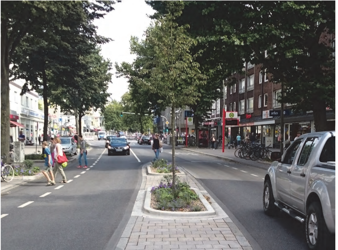
Bild 1 | Die Osterstraße nach der Umgestaltung: Mittelseln und -streifen zur Verbesserung der Überquerbarkeit, Schutzstreifen für Radfahrende und Verbesserung der Bedingungen für Zufußgehende und der Aufenthaltsqualität in den Seitenräumen
