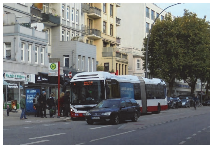
Bilder 21 und 22 | „Multifunktionsstreifen“ ohne Einbauten: im Bereich der Bushaltestelle bietet der Mittelstreifen neben der Überquerungsfunktion auch die Möglichkeit, am haltenden Bus vorbeizufahren
