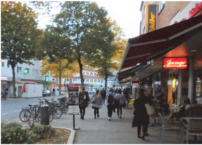
Bilder 36 und 37 | Gehflächen: in allen Teilabschnitten großzügig dimensioniert und durch die deutlich wahrnehmbare Untergliederung des Seitenraums in drei Nutzungsbereiche vor Fehlnutzungen weitgehend geschützt
