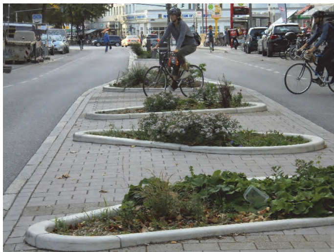
Bilder 23 und 24 | Querender Radverkehr im Streckenabschnitt: 2,00 m breite Mittelstreifen reichen nicht ganz aus (linkes Bild), der 4,00 m breite Mittelstreifen stellt dagegen auch für Radfahrende eine komfortable und sichere Überquerungshilfe dar (rechtes Bild)
